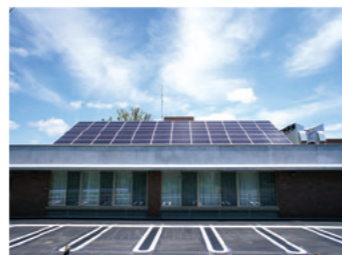
太陽光パネル
