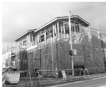
完成に向け工事が進む 第2 苫米地駅前団地
