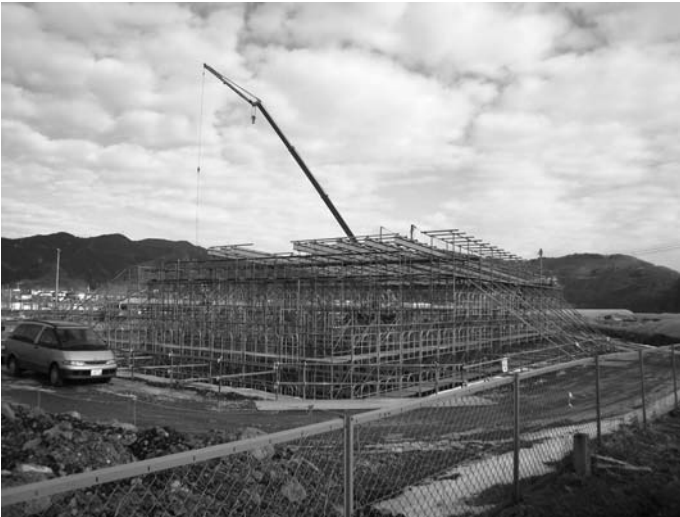
南部地区に建設中の南部町浄化センター（仮称）
