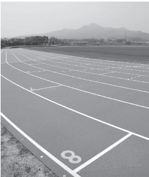
建設中のふるさと運動公園陸上競技場
