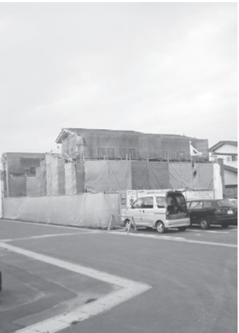
建設が進む第2 苫米地駅前団地
