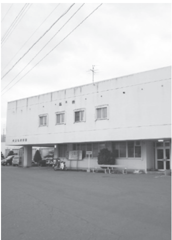
医療健康センター(仮称)に建て替えが予定されている名川病院
