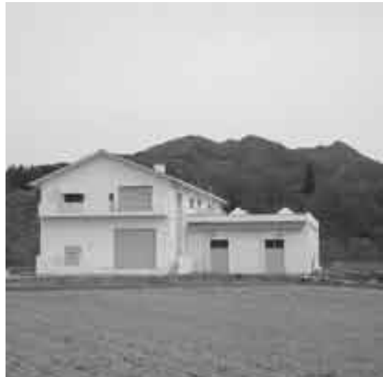
建物が完成し、機械設備及び電気設備工事中の南部町浄化センター（沖田面）
