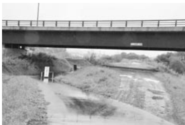
▶名久井橋下及び周辺
