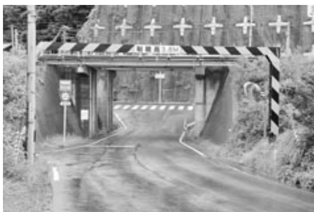
▶青い森鉄道線の諏訪ノ平ガードレール下
