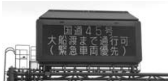
車両規制が表示される電光掲示板
