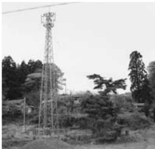
二又町内会館付近の町有地は現在、携帯電話基地局として一部利用している。（旧南部幼稚園跡地）
