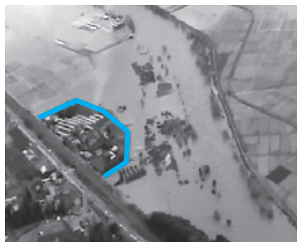
相内字上明戸地区は輪中堤整備により、昨年9月に発生した台風15号の馬淵川氾濫被害を防いだ。 ※写真上の青線が輪中堤整備を行った場所。
