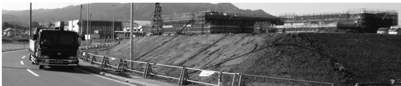
町立名川中学校（左奥）、医療健康センター（建設中）周辺の様子
