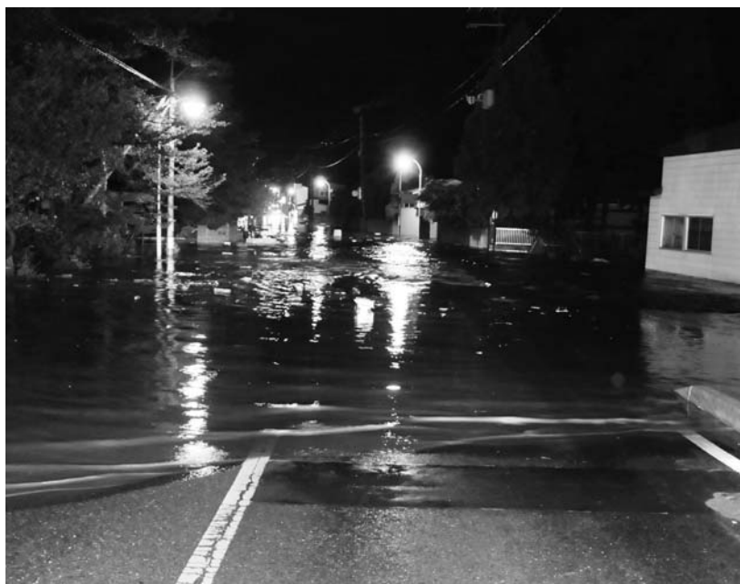
台風18号で大向地区の道路が冠水
