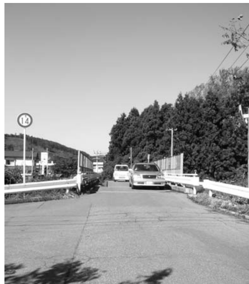
大向字中居構地区の大向道こ線橋
