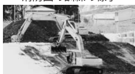
堤防の工事（南部地区大向）
