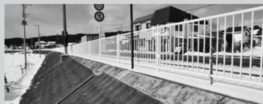
約500mにわたり設置しているフェンス
