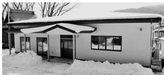
新築した諏訪ノ平公民館
