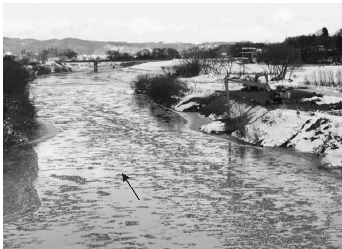
掘削工事現場：名久井橋から下流方向を撮影
