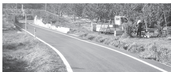
平成24年度に整備が完了した農道大向2号線
