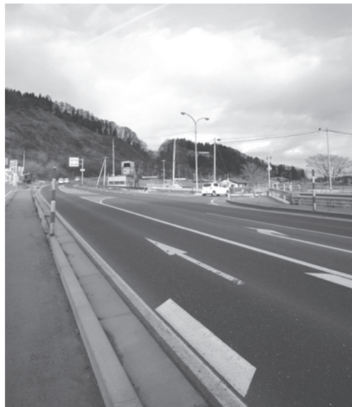
国道4号と県道軽米名川線の取り付け部分
