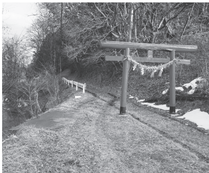
本三戸八幡宮へ続く町道の入口付近
