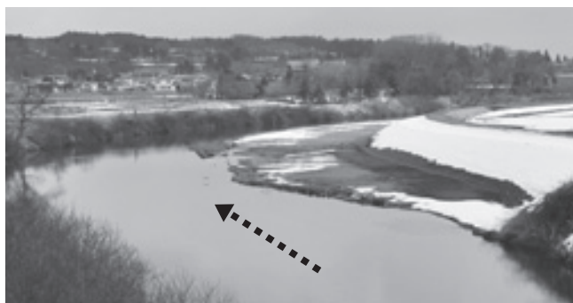
福田大橋から下流方向の右岸810mを掘削 (26年9月完了)
