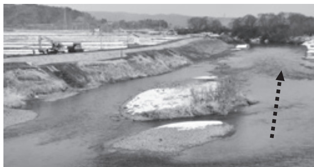
剣吉橋から下流方向の左岸300mを掘削中
