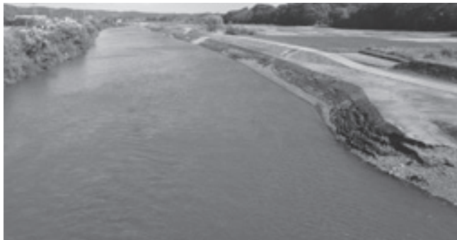
名久井橋から下流方向の右岸1,150mを掘削 (26年9月完了)
