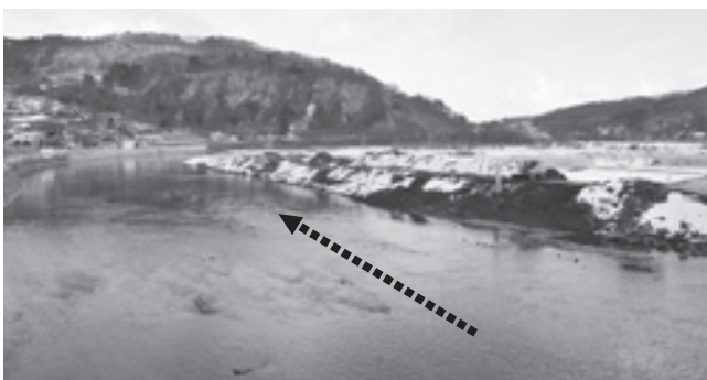
赤石橋から下流方向の右岸490mを掘削中
