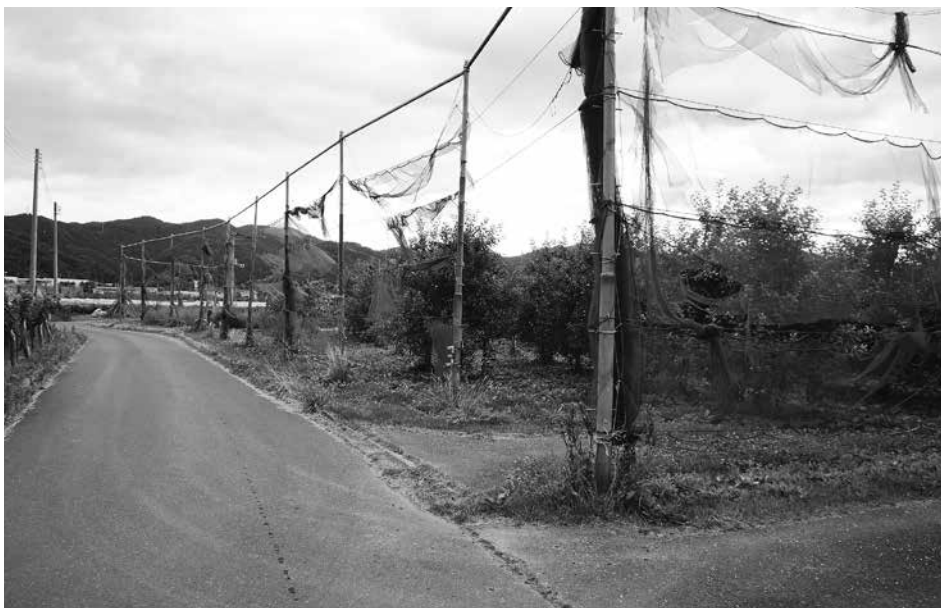
ネット（網）が破損している防風網
