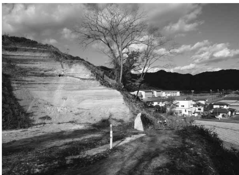
現在工事中の町道北本村・南古館線（写真中央やや右は南部中学校）
