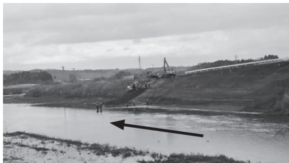
右岸を 100 m 河岸掘削。【3月完了予定】
