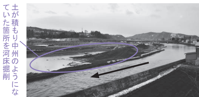
320 m 河床掘削。【3月完了予定】
