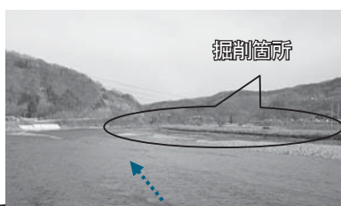
③【赤石工区】上流側から撮影
