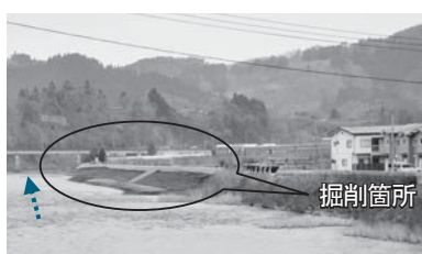
⑤【大向工区】住谷橋から撮影
