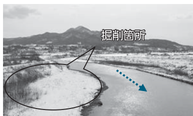
②【虎渡工区】下流側から撮影
