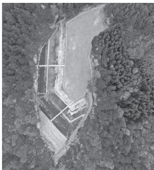
閉鎖工事完了後の福地不燃物処理場（空撮）
