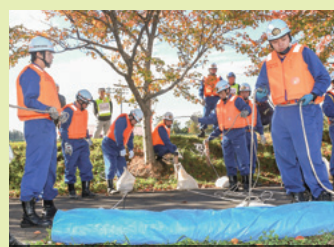
シート張り工法による水防訓練
