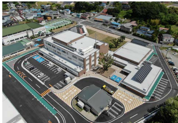
駐車場側から見た新庁舎
