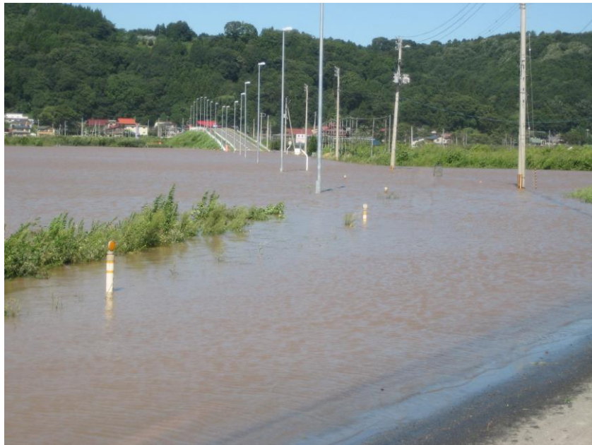
南部町（平成 25 年台風 18 号における馬淵川氾濫）水害時の様子
