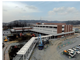
① 建物全景
