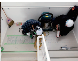
③ 誘導ブロック設置
