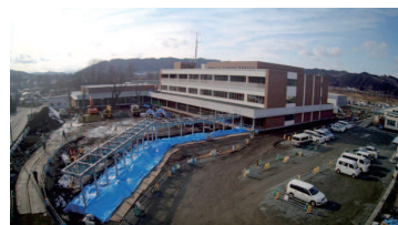
① 工事状況 全景
