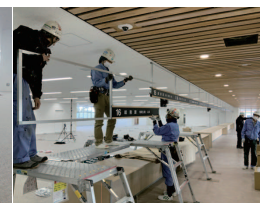
⑤ 吊りサイン設置
