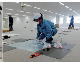
④ 床下配線取出し
