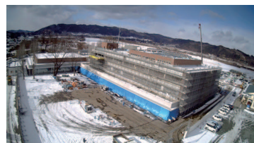
① 工事状況 全景
