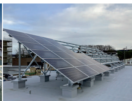
② 太陽光パネル取付け
