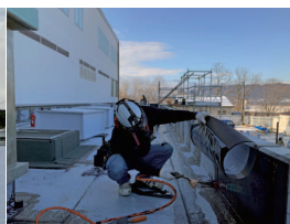
③ 屋上防水工事
