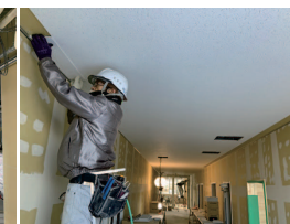
⑥ 2階 天井仕上げ
