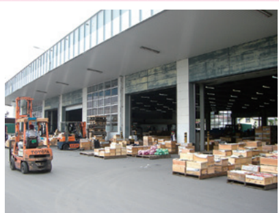
19 南部町営地方卸売市場
