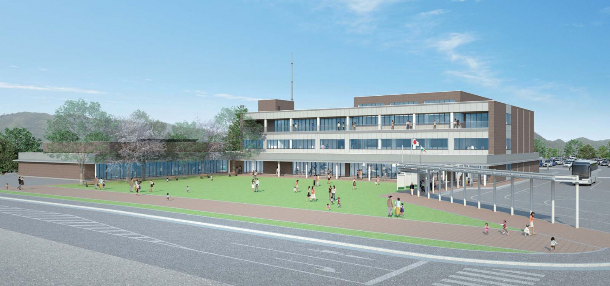
南側県道からみた外観の完成イメージ
