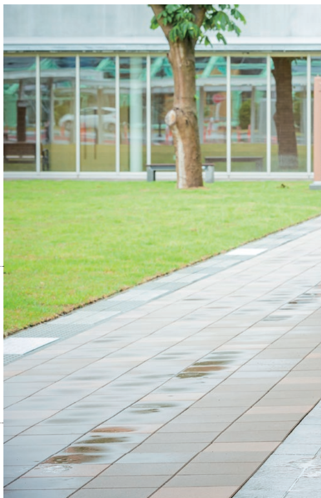
竣工した南部町役場新庁舎テラスで
