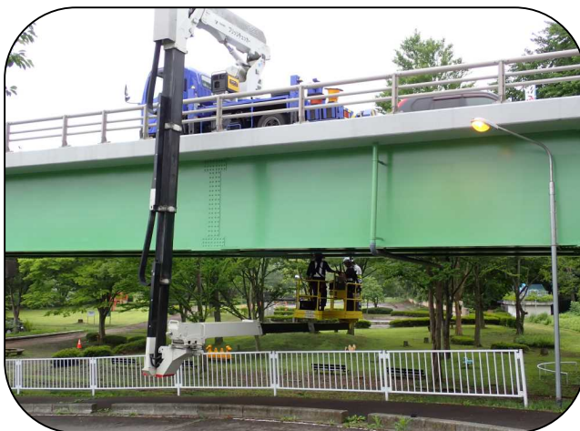
福地橋点検状況 橋梁点検車による点検
