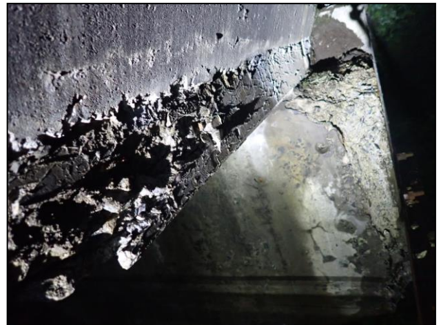
図3-5 凍害による損傷事例
