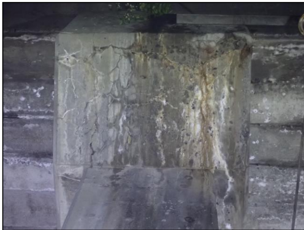
図3-5 凍害による損傷事例
