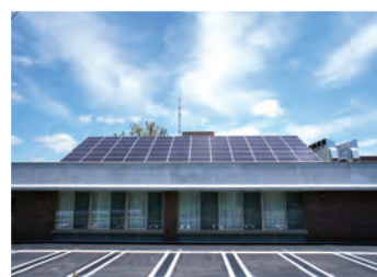
太陽光パネル
