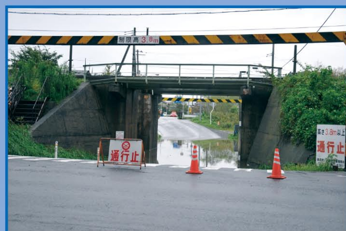
平成23年9月22日 高瀬橋付近
