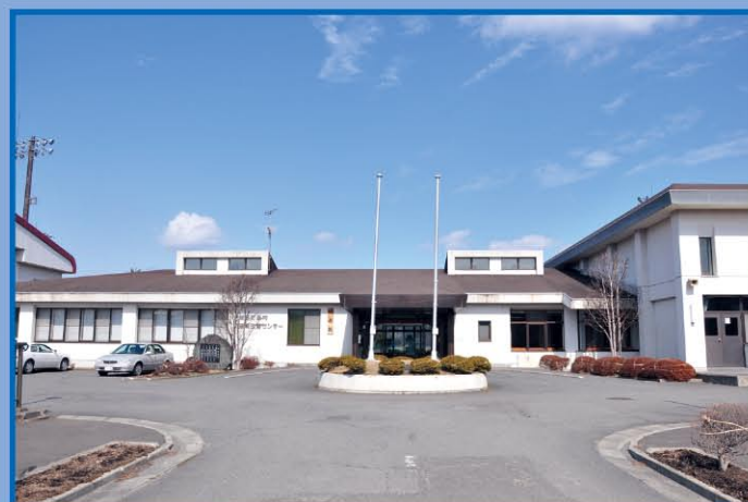
農村環境改善センター 福寿館
