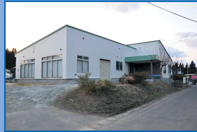
法師岡コミュニティ防災センター
