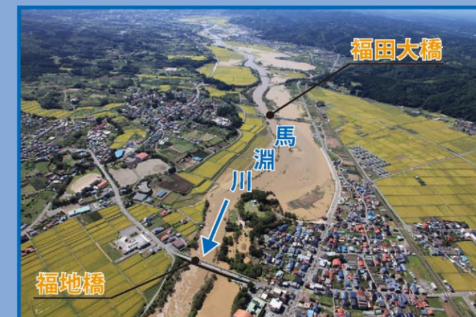
平成25年9月16日 福地橋・福田大橋周辺
