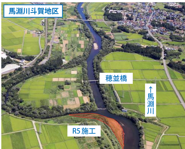
令和5年度 工事着手・完了 施行区間：L=650m 工事内容：雑木伐採、掘削
