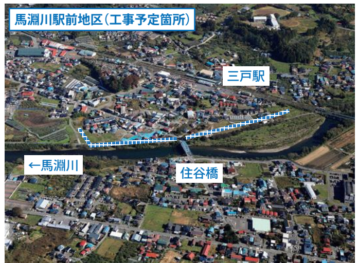
令和6年度 着工予定 施工箇所 N=1箇所 工事内容：樋門工事
