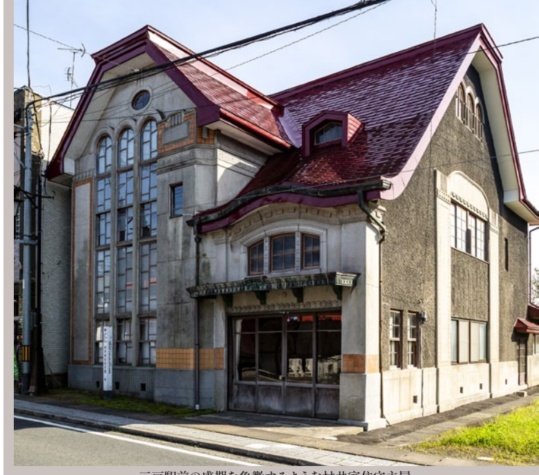
三戸駅前の盛期を象徴するような村井家住宅主屋。 大正12年（1923）に竣工した大正モダニズムの 和洋折衷住宅（国有形文化財）
