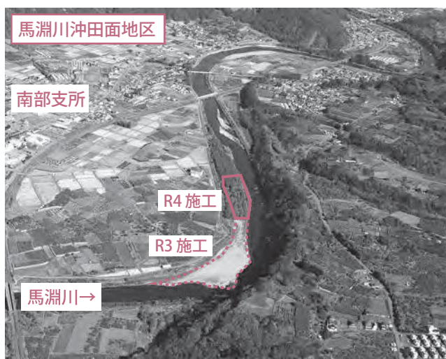
令和4年度 工事着手・完了 施工区間 L=200m 工事内容：雑木伐採、掘削
