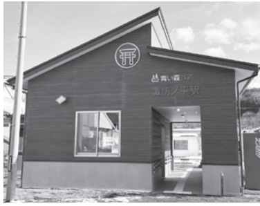
令和8年2月から供用が開始された新駅舎「諏訪ノ平駅」
