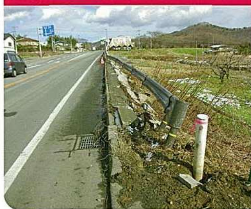
ガードレール・標識等の損傷
