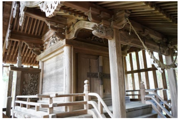
⑨——町文化財に指定された本三戸八幡宮本殿
