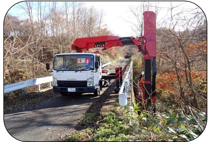
葉柴山2号橋点検状況 【橋梁点検車による点検】
