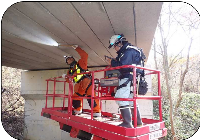
葉柴山2号橋点検状況 【橋梁点検車による点検】
